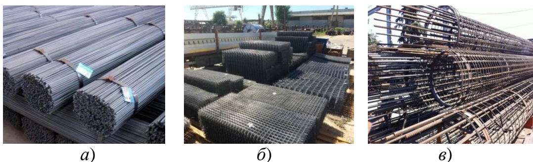
Рис. 1.1. Складирование арматурных изделий на приобъектном складе: а – пачки с арматурой; б – арматурные сетки; в – каркасы
